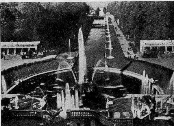
Peterhoff.—La avenida de las fuentes.
